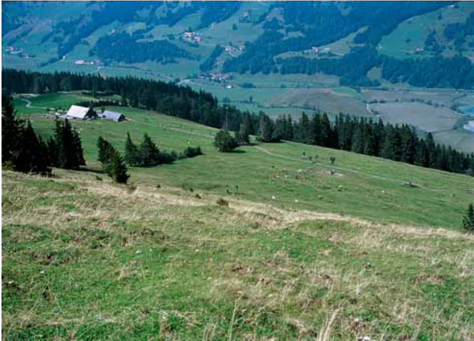
Abb. 1: Blick auf die ehemaligen Pistenflächen und die Alpe Große Starkatsgund. Im Vordergrund die rekultivierte Fläche einer ehemaligen Schlepplift-Stütze mit Betonfundament.
