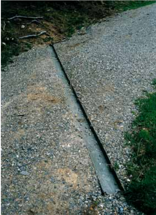
Abb. 11: Die zu Wasserableitern umfunktionierten ehemaligen Liftstützen erfüllen ihre Funktion (kombinierter Forst- und Wanderweg zwischen Alpe Große Starkatsgund und Naturfreundehaus).
