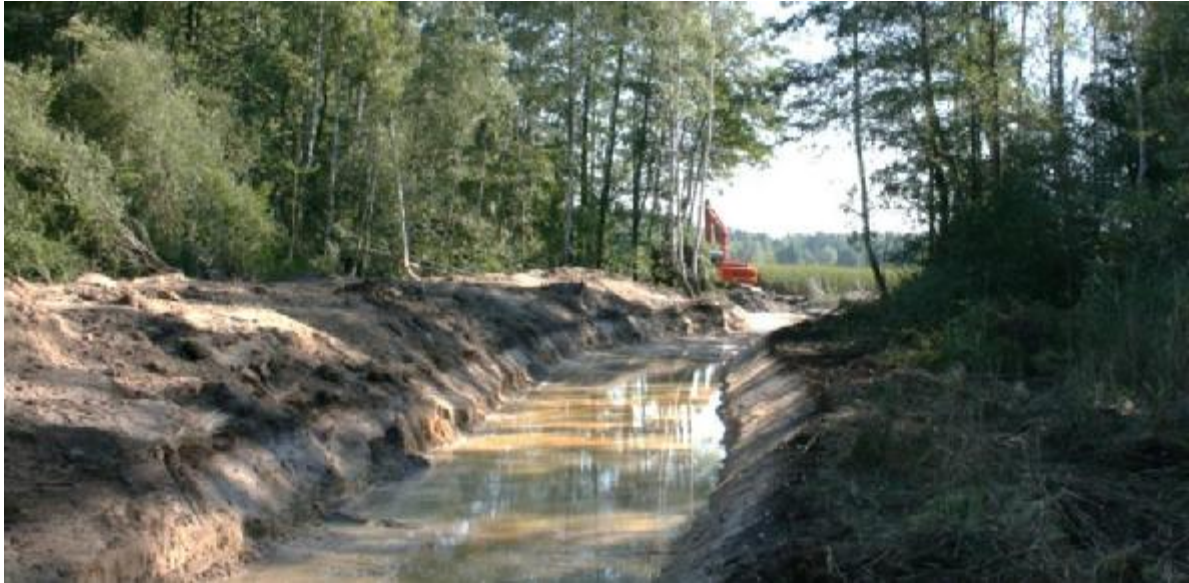
Abb. 5: Anlage des nördlichen Ablaufgrabens.
