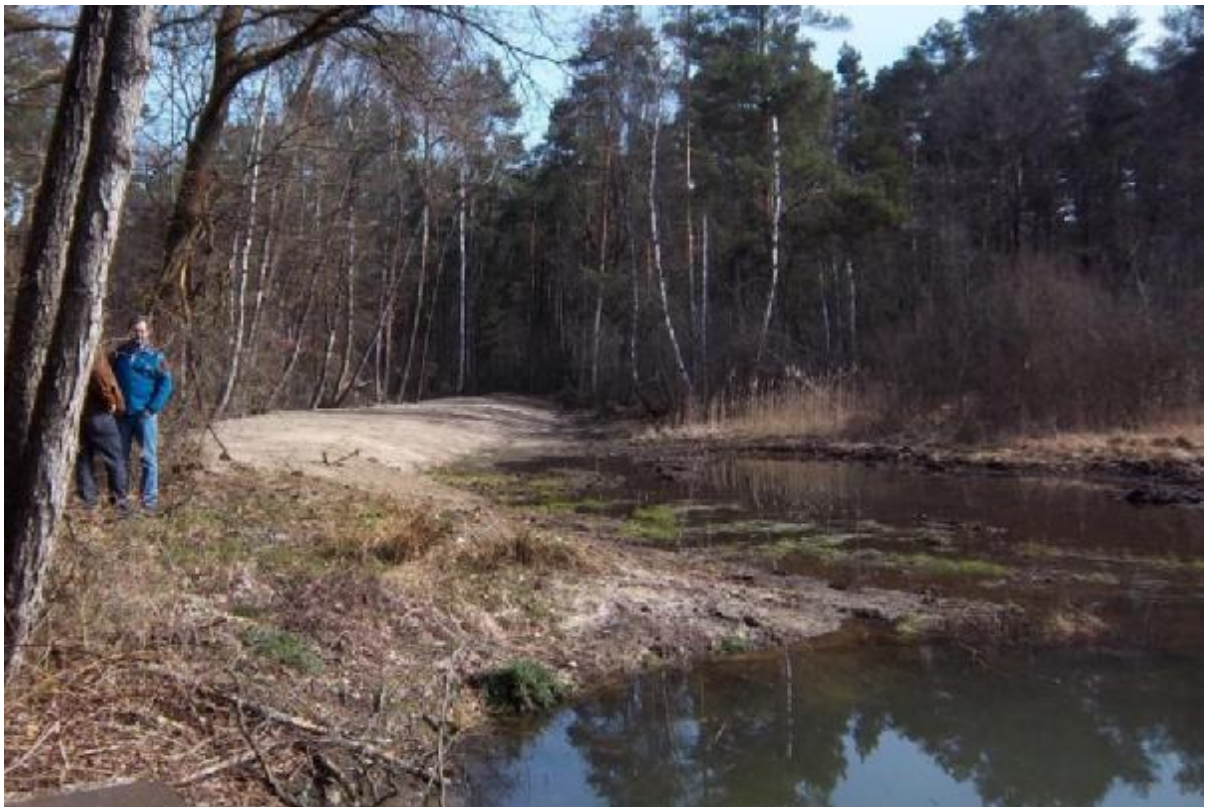
Abb. 14: Die zusätzliche Dammverstärkung oberhalb des nördlichen Mönches.
