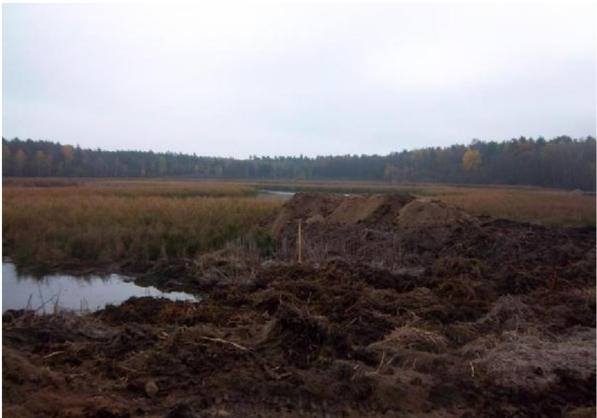
Abb. 16: Die zentrale Wasserfläche und der Grabenaushub zur Modellierung der Flachwasserzonen. Davor ein Pfosten mit der Markierung der angestrebten Wasserspiegelhöhe.
