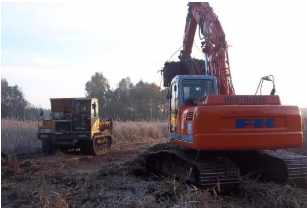
Abb. 9: Einsatz von Moorbagger und Kettendumper zur Anlage der Grabenstrukturen im Schilf.
