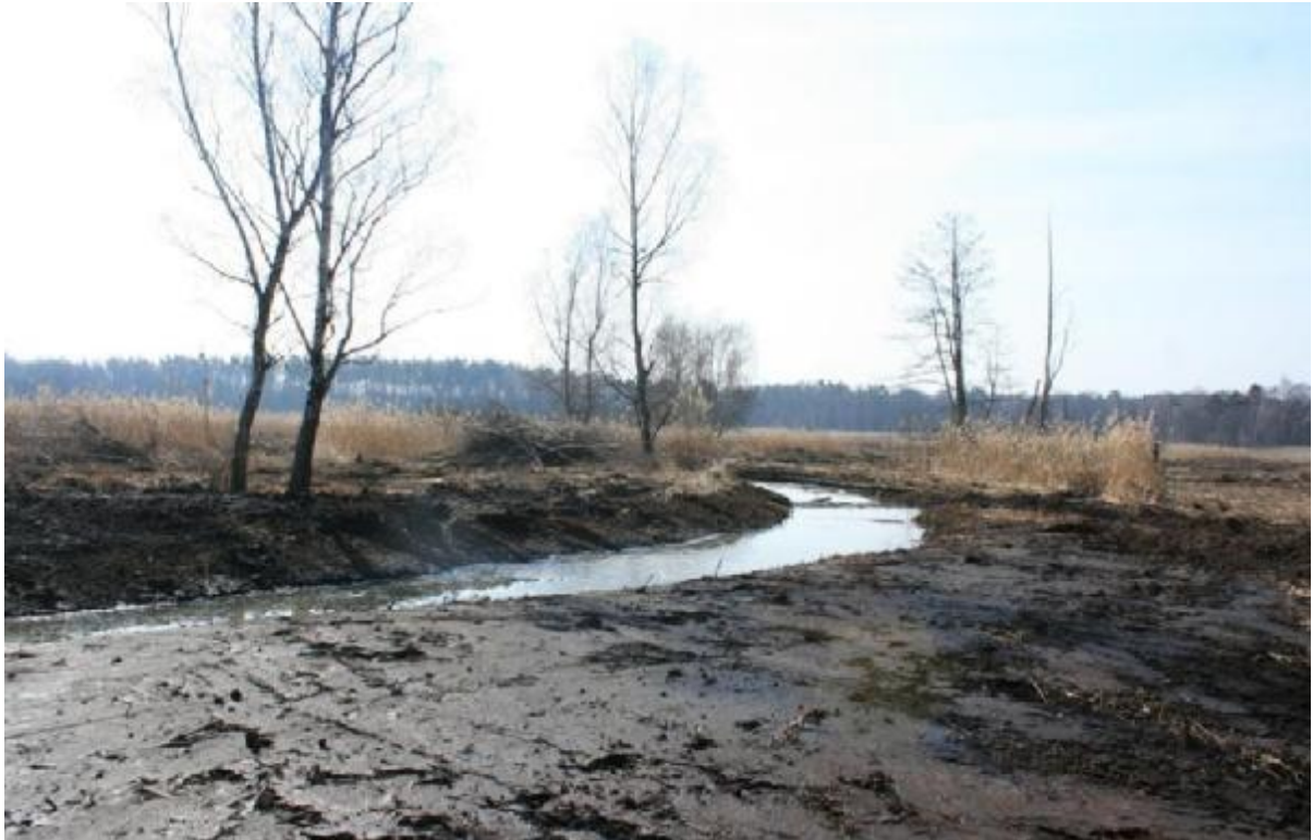
Abb. 20: Der neue Zulaufgraben bildet einen Bestandteil des Grabennetzes im nordöstlichen Schilfbereich. Das Wasser wird jetzt gesammelt bis weit in die Weiherfläche hineingeleitet.
