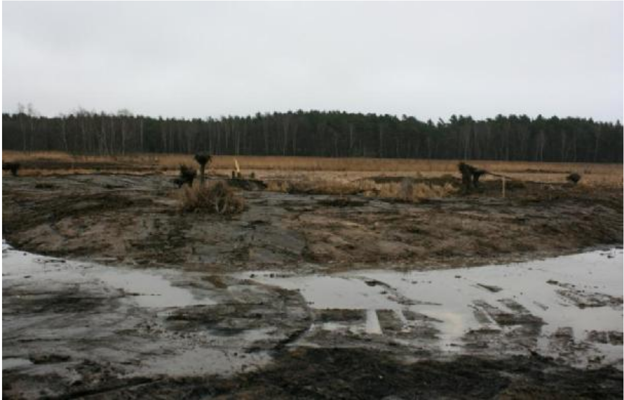
Abb. 19: Die Nördlichste der Flachwasserzonen am Westrand der offenen Wasserfläche besteht aus festerem Material und konnte als U-Form mit zentralem Kolk modelliert werden. Hier besteht jetzt eine geschützte Rückzugsmöglichkeit für Fische. Die eingebrachten Wurzelteller und Baumstämme bieten Ansitz- und Nistmöglichkeiten für verschiedene Vögel. Rechts ein Pfosten mit Wasserspiegelmarkierung.
