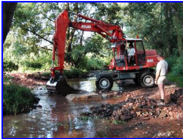
Die Bauarbeiten wurden von Mitarbeitern der Flussmeisterstelle Salz geleitet.
