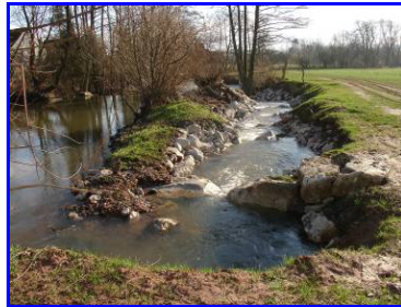
Eines der neu angelegten Umgehungsgerinne.
